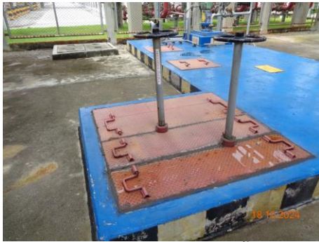
ภาพที่ 2.2-15 ประตู/วาล์วระบายน้ำที่เชื่อมกับ บ่อบำบัดน้ำฝน
