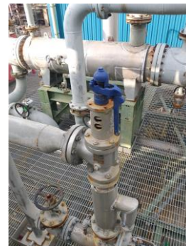
ภาพที่ 2.2-30 วาล์วนิรภัย (Pressure Safety Valve)
