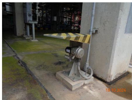
ภาพที่ 2.2-2 Gas Detector บริเวณหน่วยการผลิต
