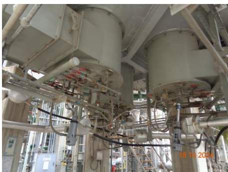
ภาพที่ 2.2-1 ระบบ Low NO x Burner
