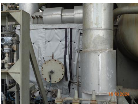
ภาพที่ 2.2-6 วัสดุปิดครอบอุปกรณ์และเครื่องจักร
